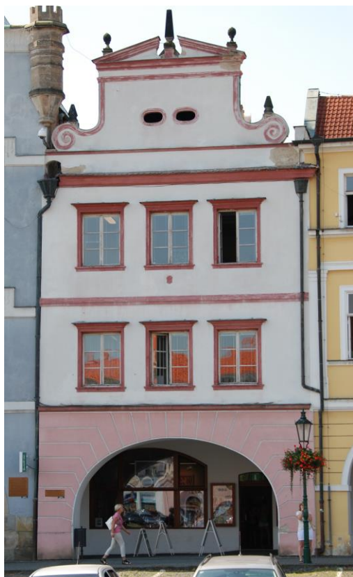
Vlevo před opravou
