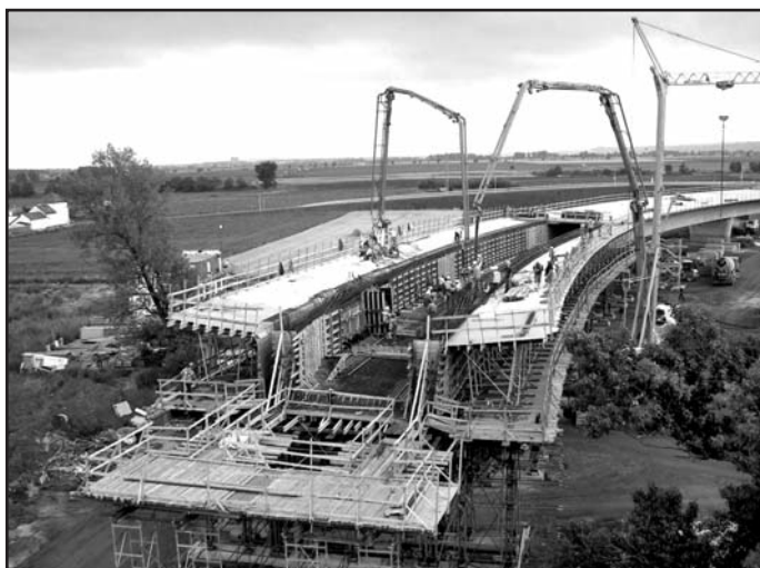
Náročnost stavby je zřejmá ze snímku, který zachycuje betonáž taktu na pevné skruži.
