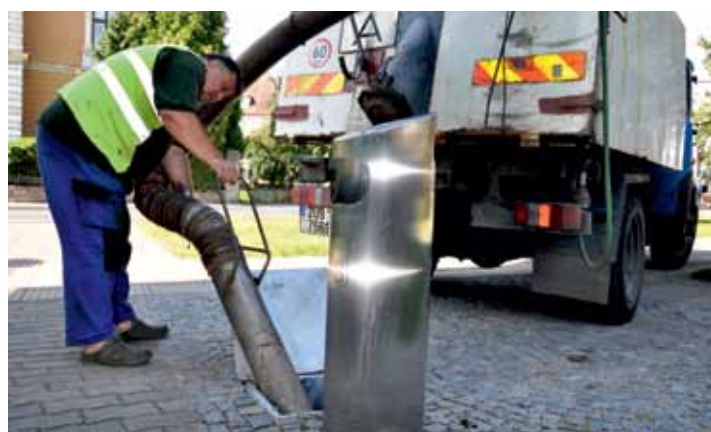
Vývoz podzemního odpadkového koše u pokratických závor zajišťují pracovníci Technických služeb města. Nad zemí vyčnívá pouze koš z nerez, vedle kterého je železný poklop, kterým je odpad vysáván. Fota Eva Břeňová
