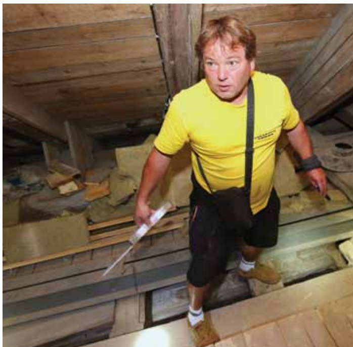
Zdeněk Oravec při opravě krovů Kalichu.
